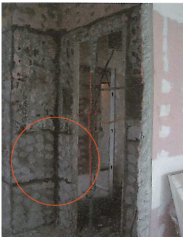
輕隔間切割敲除
