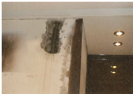
冷氣排水敲打至結構體
